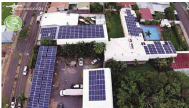
Paneles Solares. Foto tomada de Audivisual Cañas
